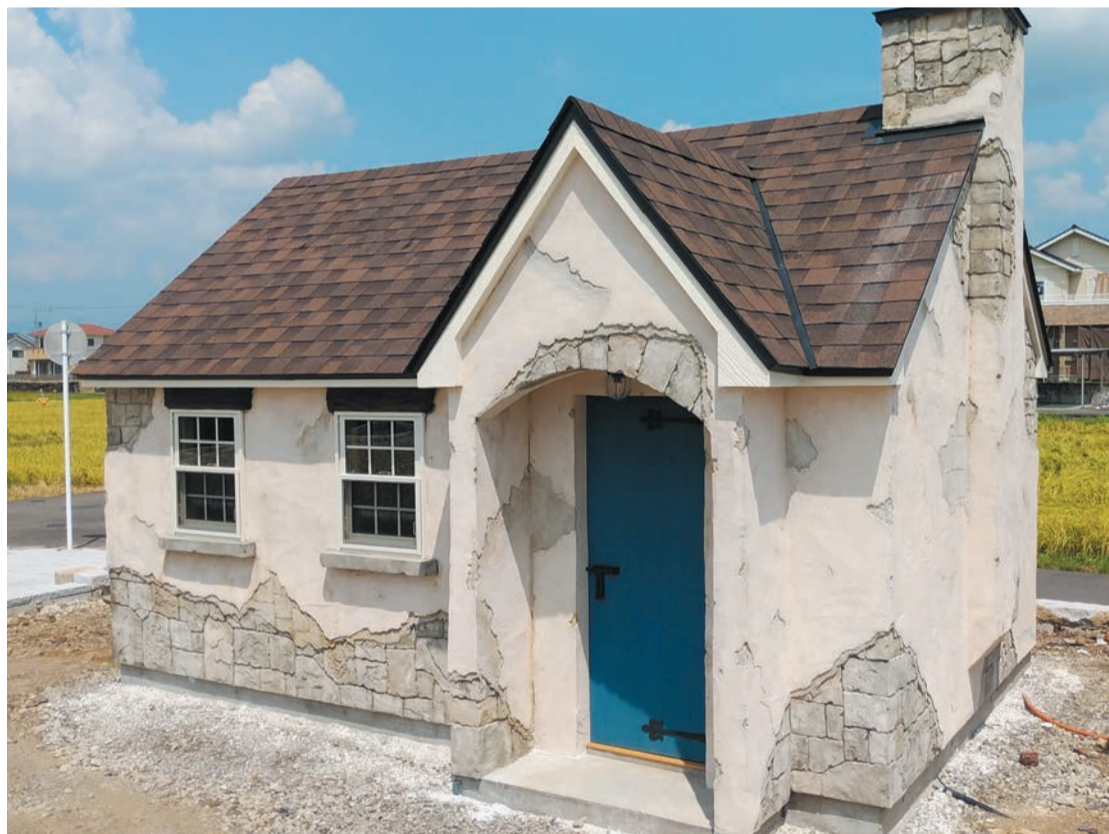
こちらは展示場の造形小屋よりサイズアップした大きさまでのご希望で施工。小屋のサイズにより、屋根の高さ、アーチの大きさなども変化します。そして石や壁の造形も展示場の小屋とはまったく同じにはなりません。色もそうです。このようにモルタル造形小屋は同じものがひとつとない、世界でただひとつ、あなただけの小屋になるのです。
