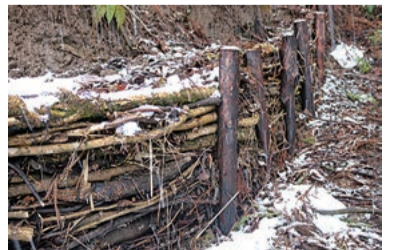
上の写真がしがらみ。大小の枝や稲わら、落ち葉を絡ませ組み上げたもの。土が崩れるのを防ぎ、また土中の微生物を元気にする仕組み。
