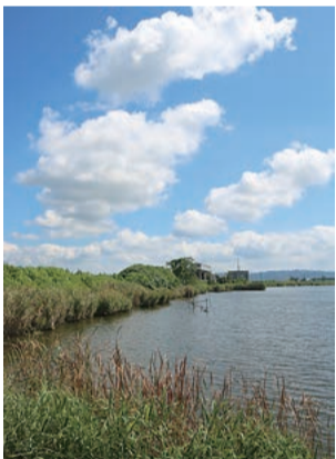
金沢港防潮水門
