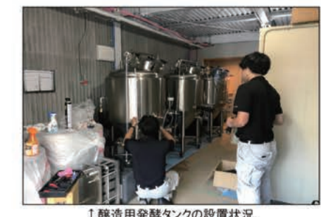
↑醸造用発酵タンクの設置状況
