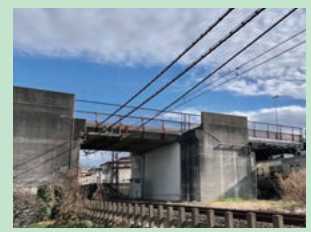
▲東上線の上に架かる足立陸橋 柳瀬川駅側も歩道が設置可能な構造
