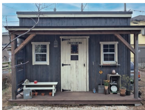
完成すると無垢材の外壁に囲まれた美しい姿が現れます。そしてその後は好きな色で塗装してください。クリア塗装で木目を生かすのも素敵です。劣化を防ぐためにも塗装は必ず行ってください。
