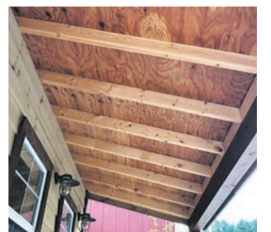
屋根がそのままグリーンと延長されてウッドデッキの端まで覆い隠されます。屋外だけど屋外じゃないような特別なスペース。
