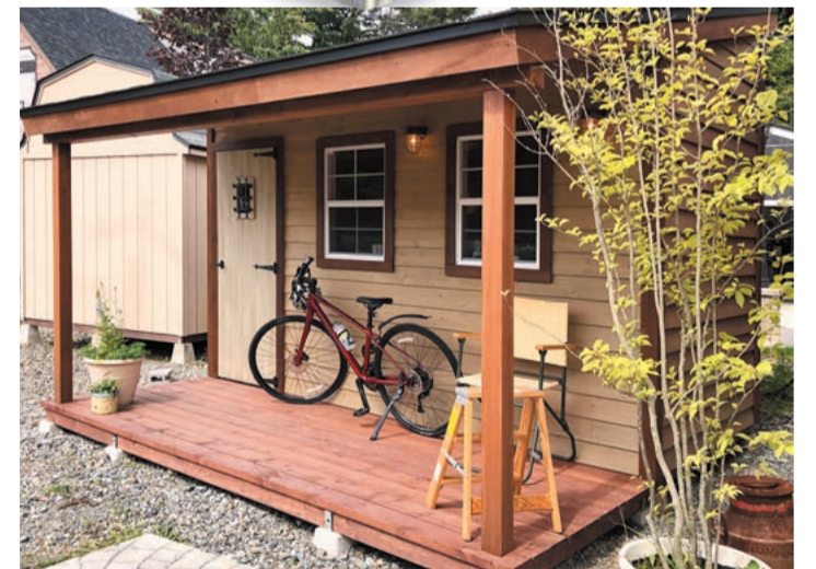
ドアはナチュラルシリーズ共通の無垢のレッドシダーを1枚ずつ張り合わせて製作している1点もので重みがあります。外壁はスタイル03と同じ福杉のベベルサイディング。小屋にはびったりの外壁です。
