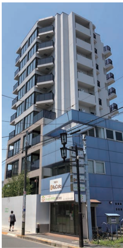
解体が決まったマンションの外観
