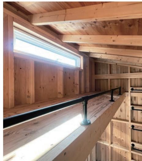
完成後の室内はパネルの柱が美しく並びます。天井が高いスタイル02は開放感があり、長めのモノの収納に便利です。高い天井を利用してロフトを作れば、収納量もアップします。※ロフト・ハシゴは製品には含まれません。
