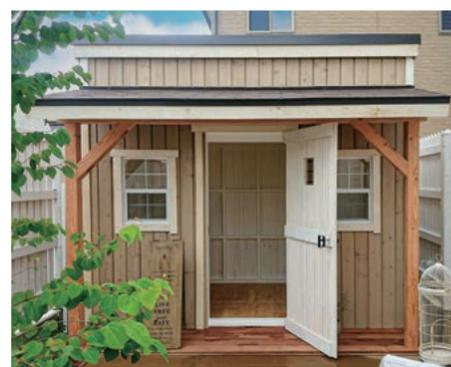
完成すると無垢材の外壁に囲まれた美しい姿が現れます。そしてその後は好きな色で塗装してください。クリア塗装で木目を生かすのも素敵です。劣化を防ぐためにも塗装は必ず行ってください。
